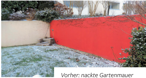
Vorher: nackte Gartenmauer
